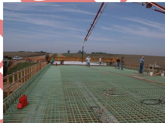
(d) 'Epoxy bridge' deck concrete placement
